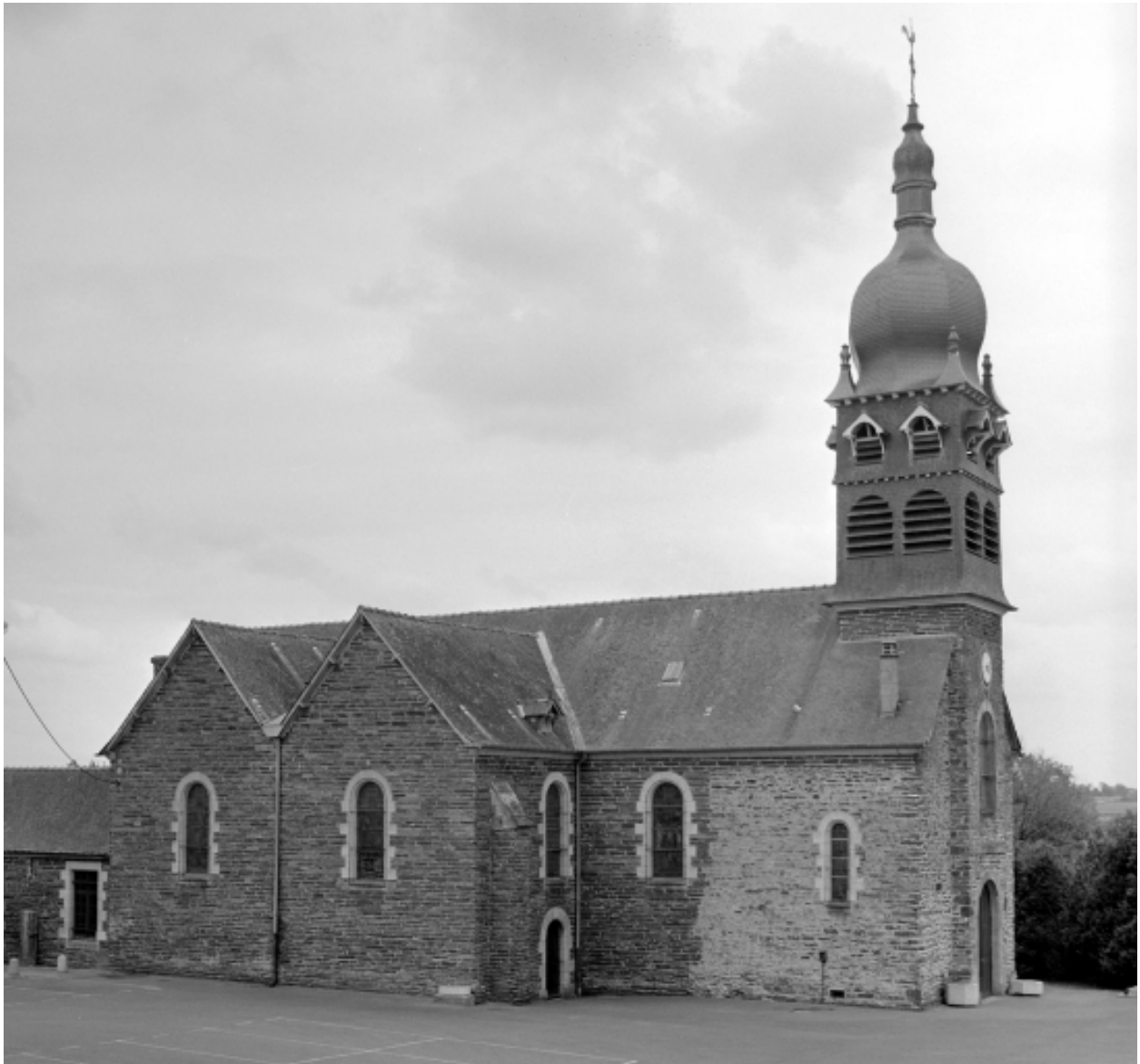
Elévation Nord-Ouest : vue générale
