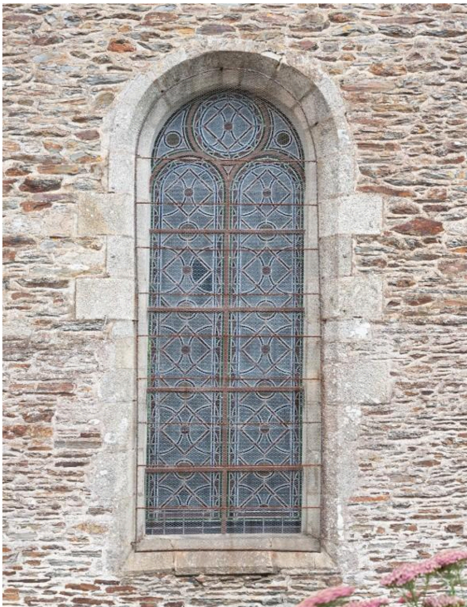
Ouverture chapelle sud du transept
