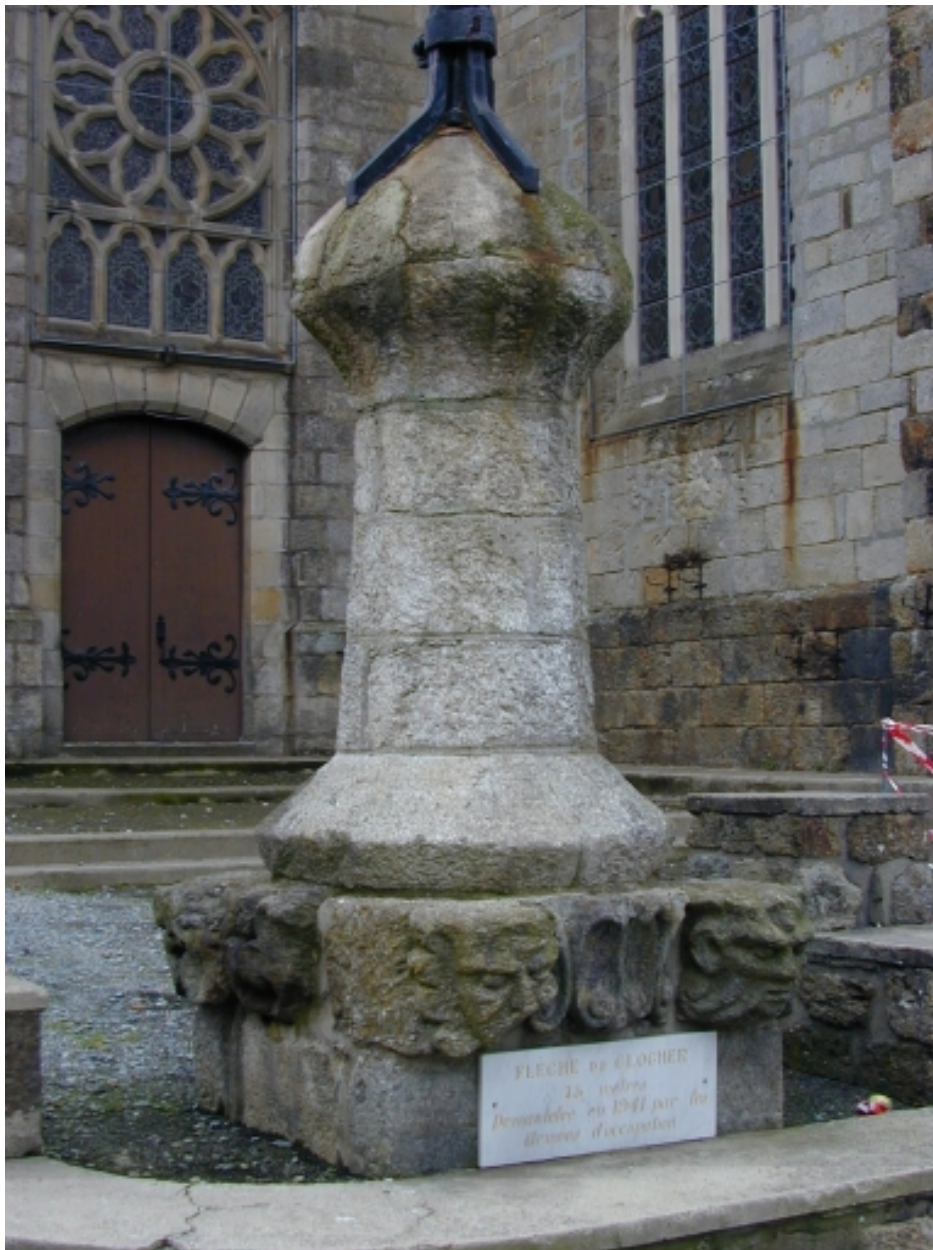
Amortissement de la flèche démantelée en 1941
