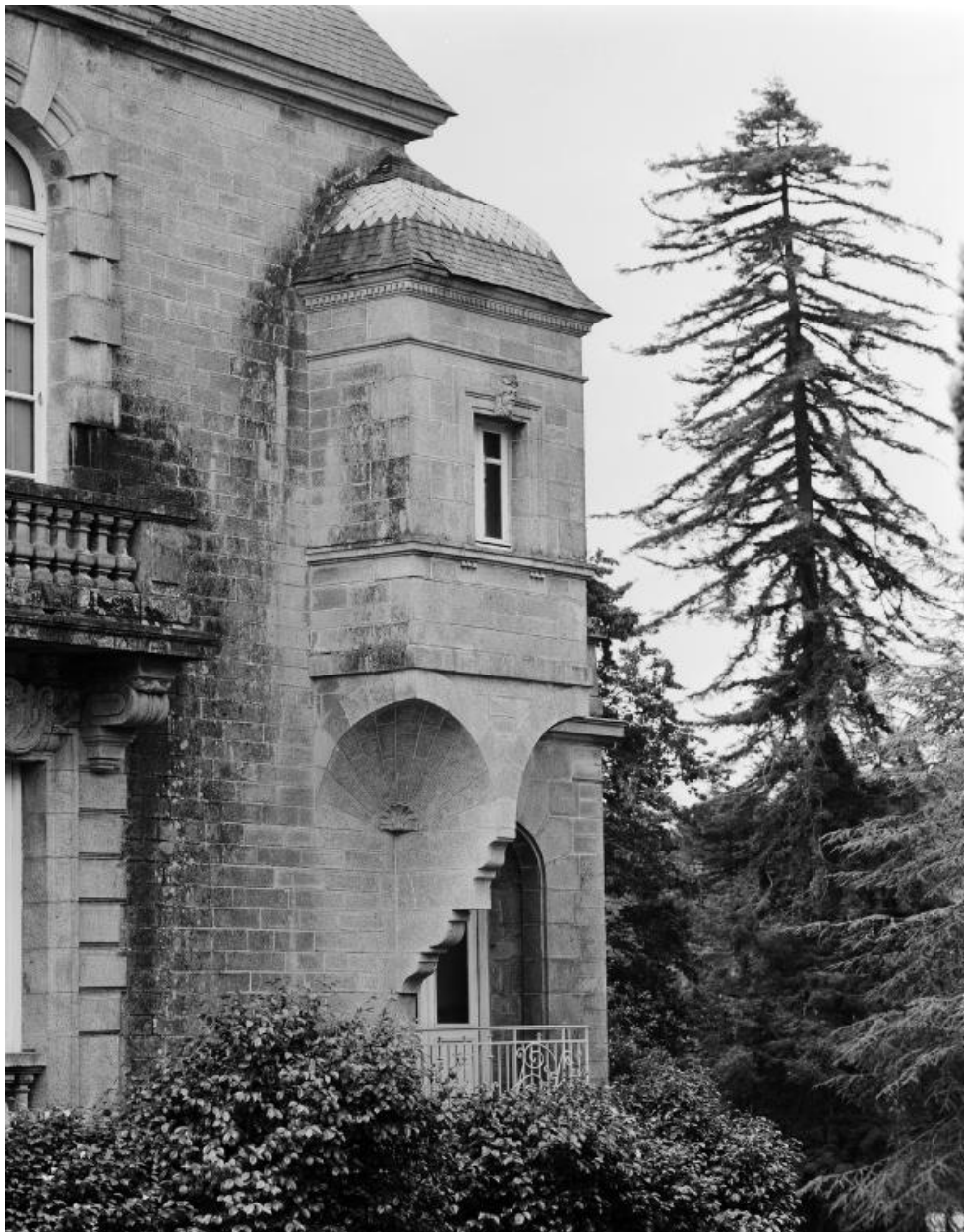
Château, logis, pavillon ouest, échauguette sur trompe.
