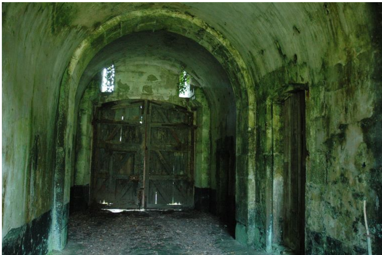
Vue du fort de Penfeld : la porte et le passage d'entrée
