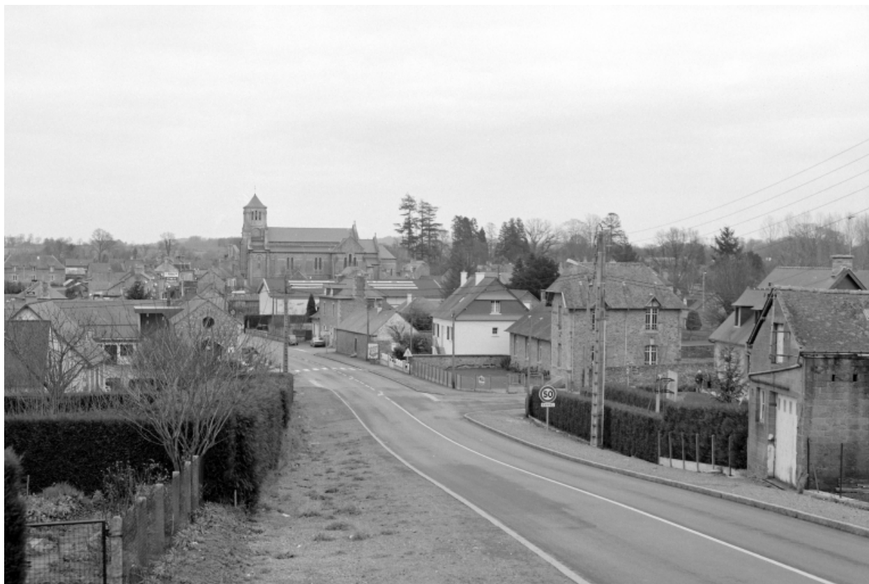
Elévation Ouest : vue de situation
