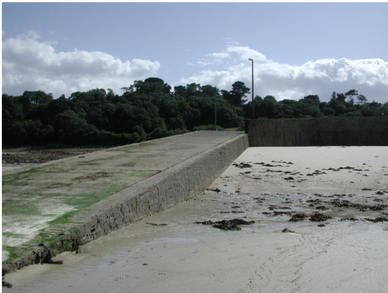
Vue de la cale côté Ouest qui prolonge le quai
