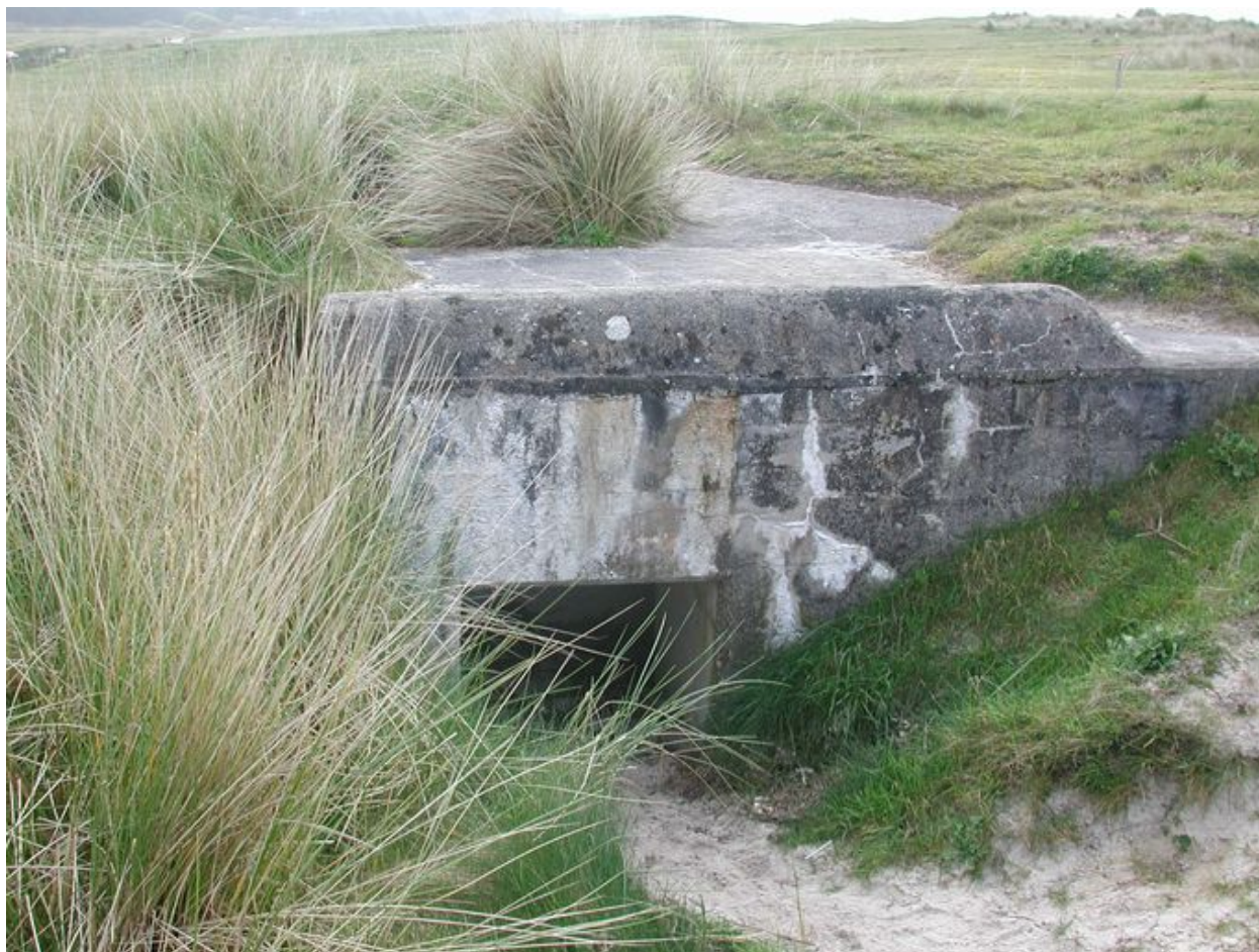
Vue d'un bunker-abri : entrée (état en 2003)
