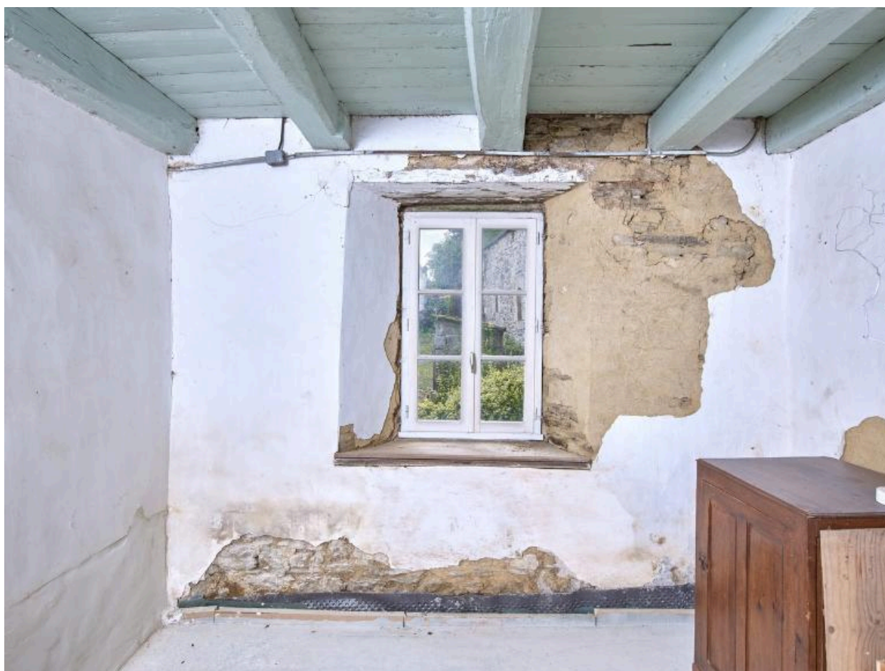
Logis 1831. Pièce du rez-chaussée. Mur enduit de terre et recouvert de lait de chaux
