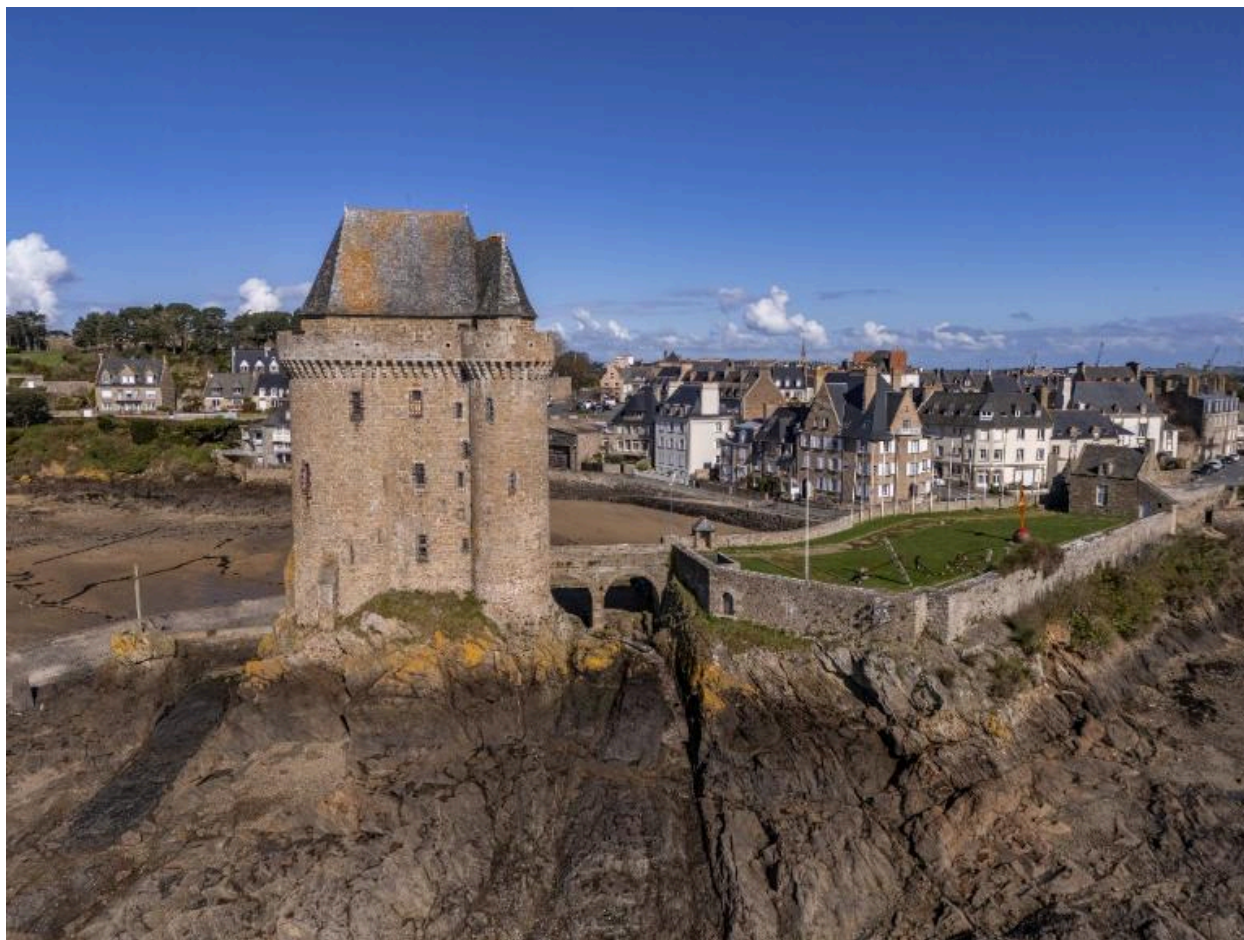
Vue aérienne oblique depuis le sud : tour, pont et basse-cour. En arrière-plan, Saint-Servan
