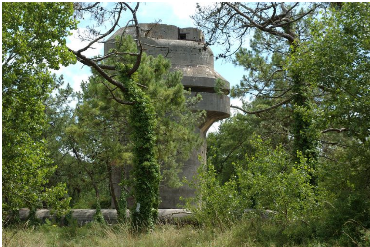
Vue de l'ensemble fortifié Karola : poste de direction de tir de type S 497
