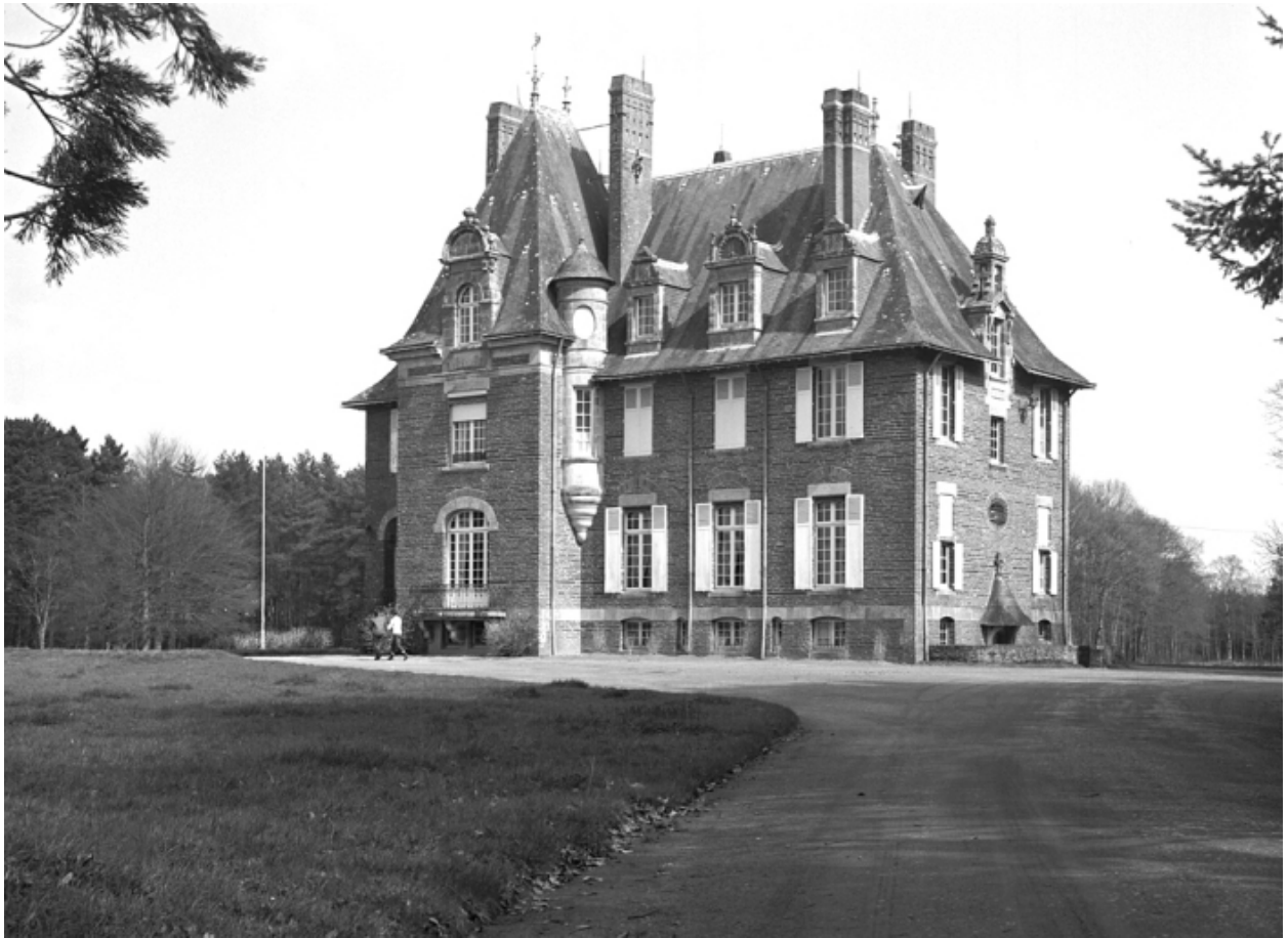
Vue générale sud-ouest en 1982
