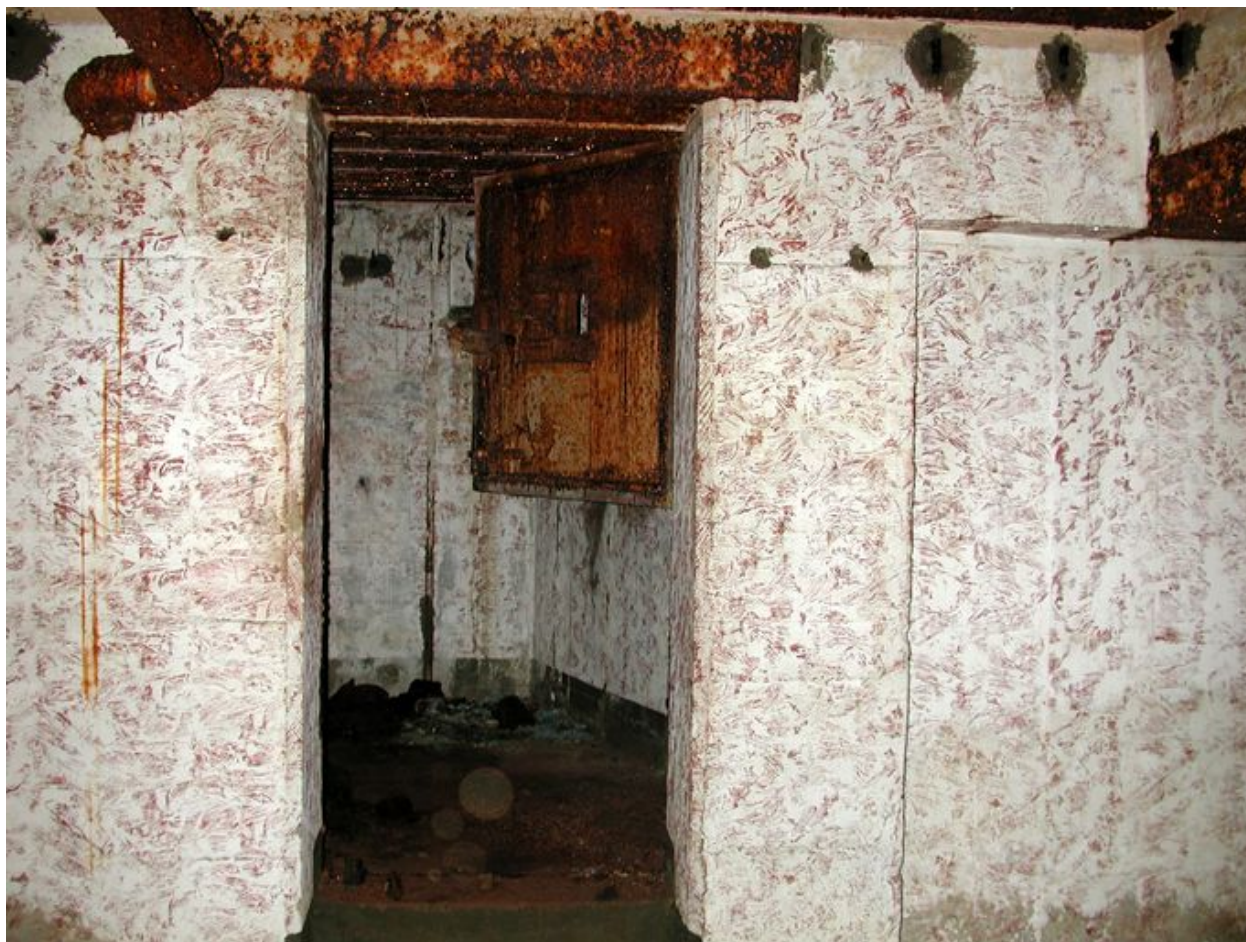
Vue du bunker - casemate de type 634 de Kerriou à Saint-Anne du Portzic (B 97 / 15) : intérieur décoré en ocre rouge moucheté imitant une tapisserie, état en 2003
