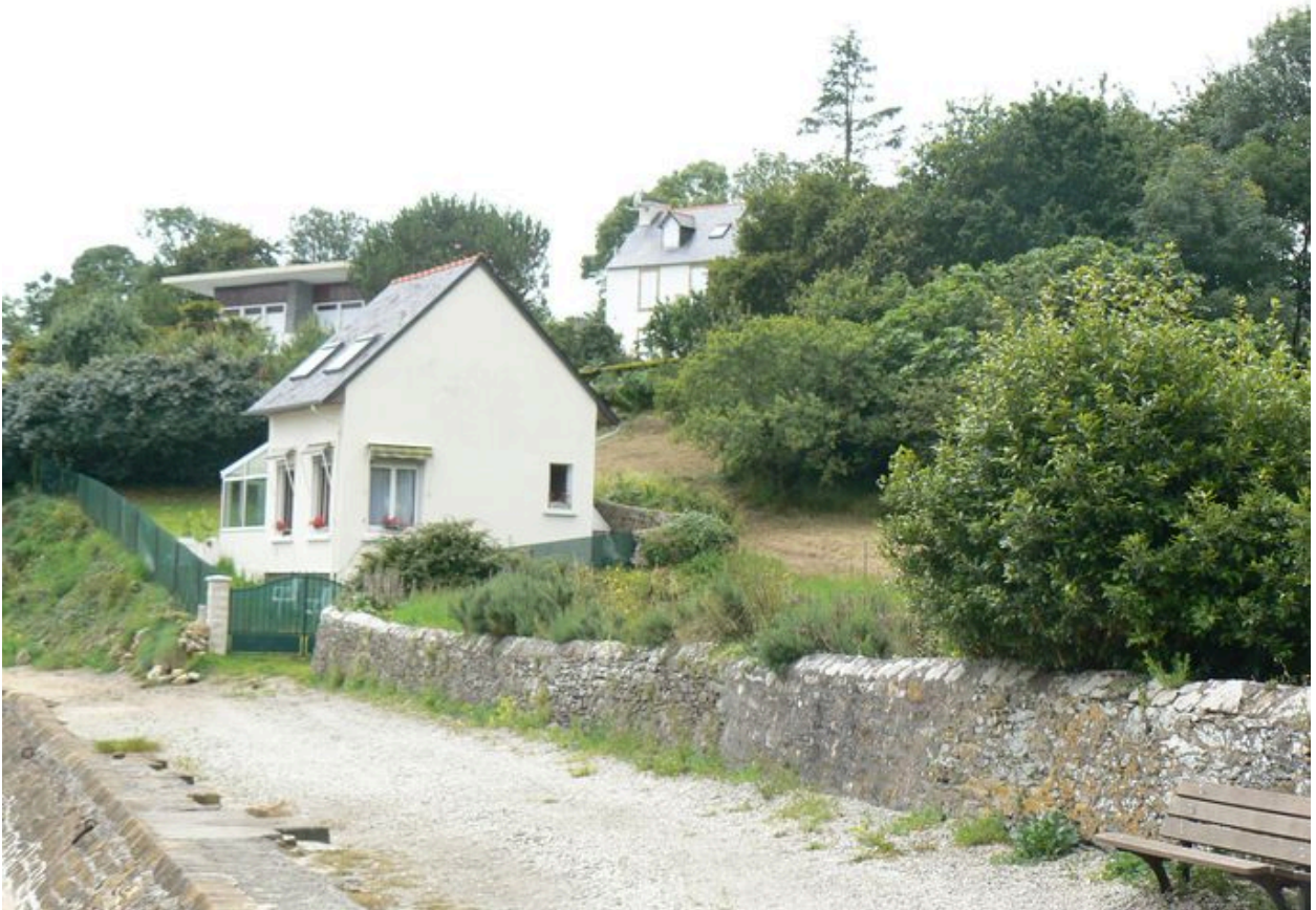
Vue générale de la maison du gardien du four à chaux
