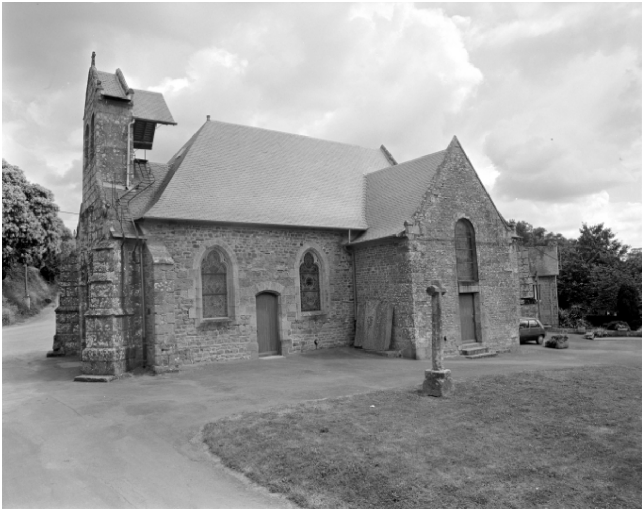
Elévation Sud : vue générale
