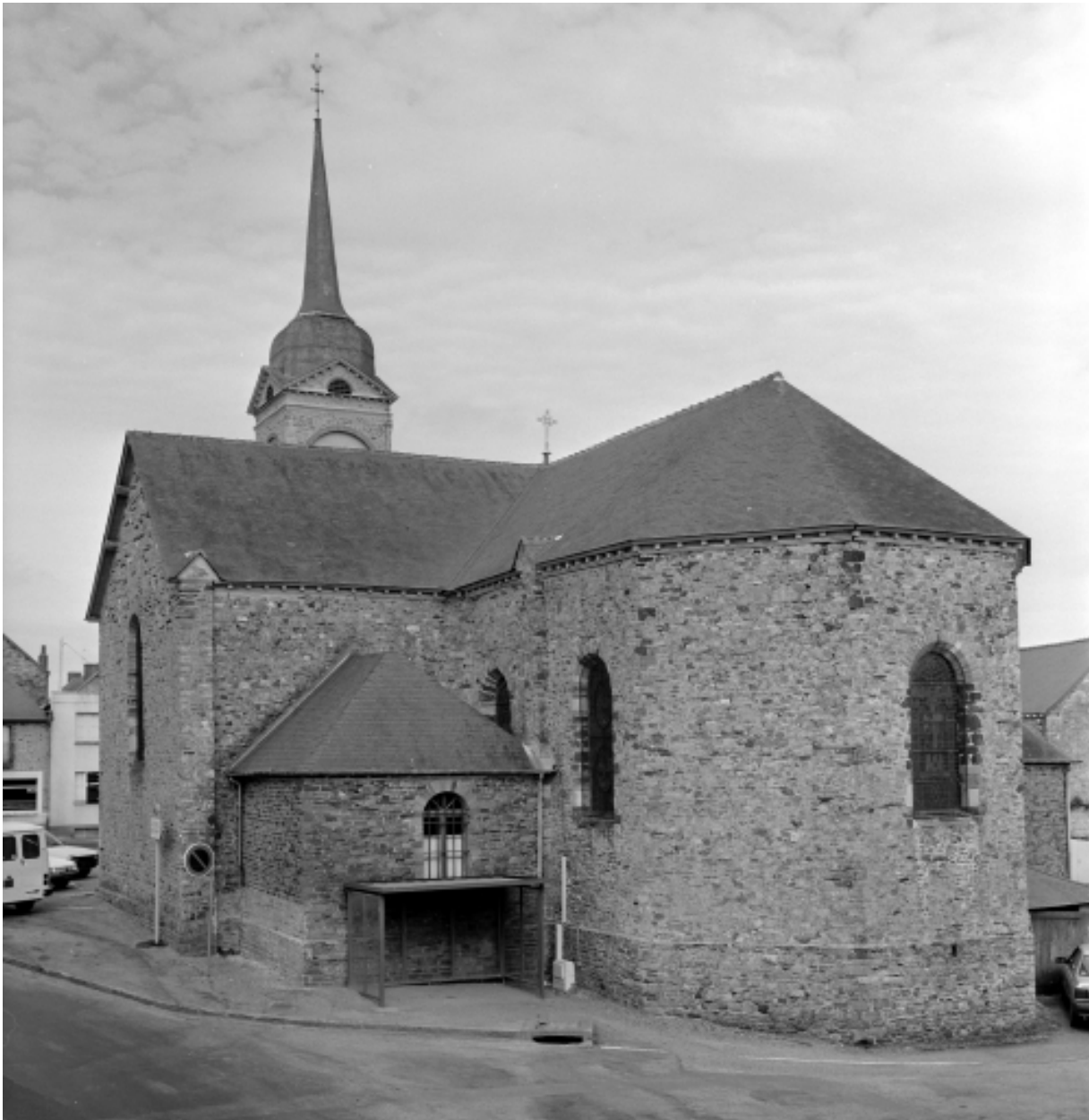
Élévation est : vue générale
