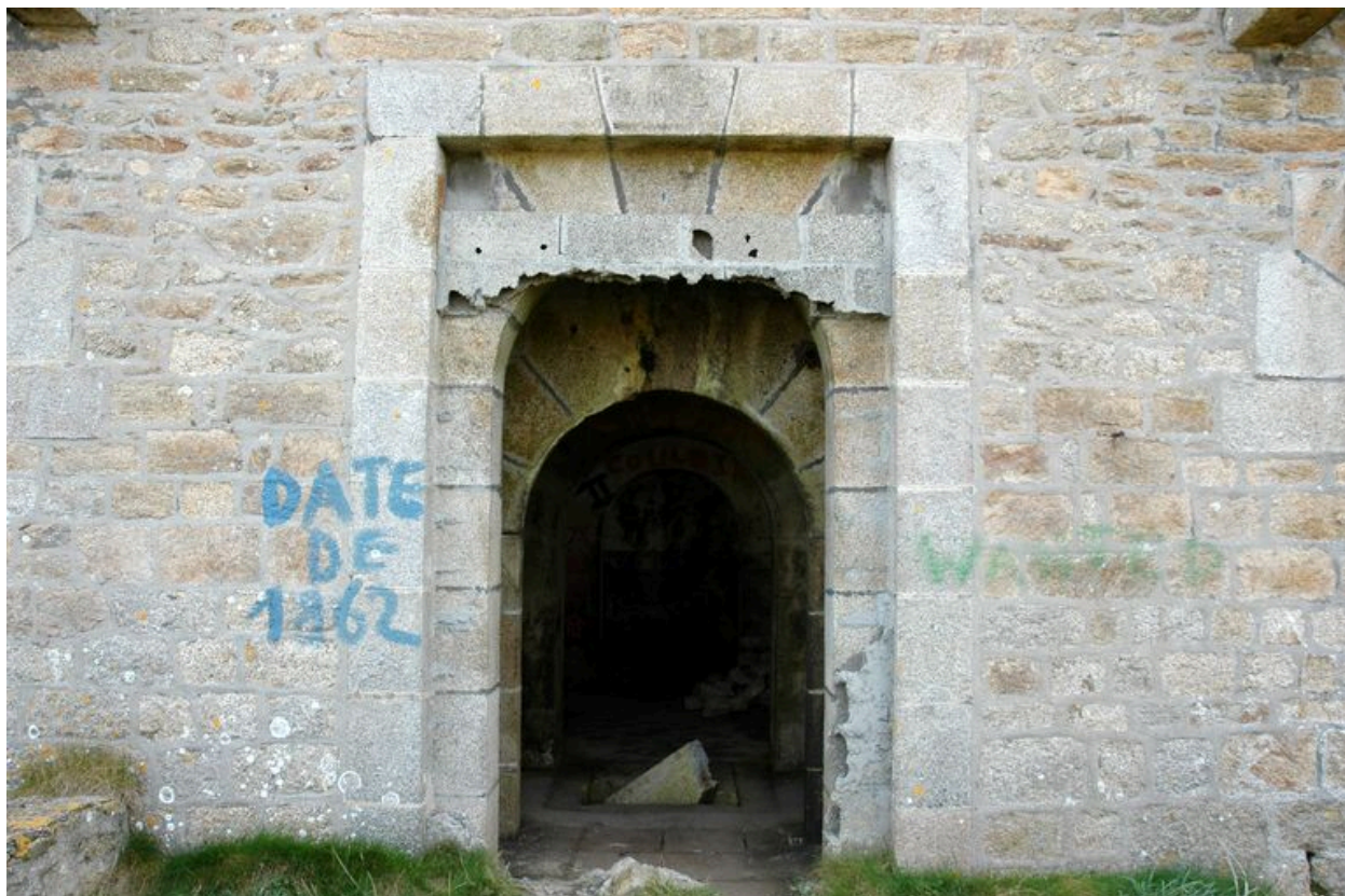
Vue du réduit de batterie de côte de Loqueltas, entrée
