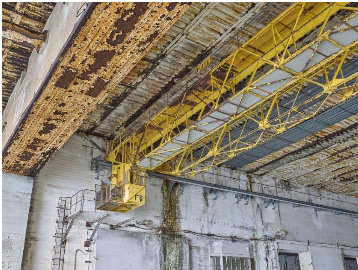
Vue de l'entrée de l'alcôve G (n° 13 et 14) : pont roulant d'une capacité de 5 tonnes
