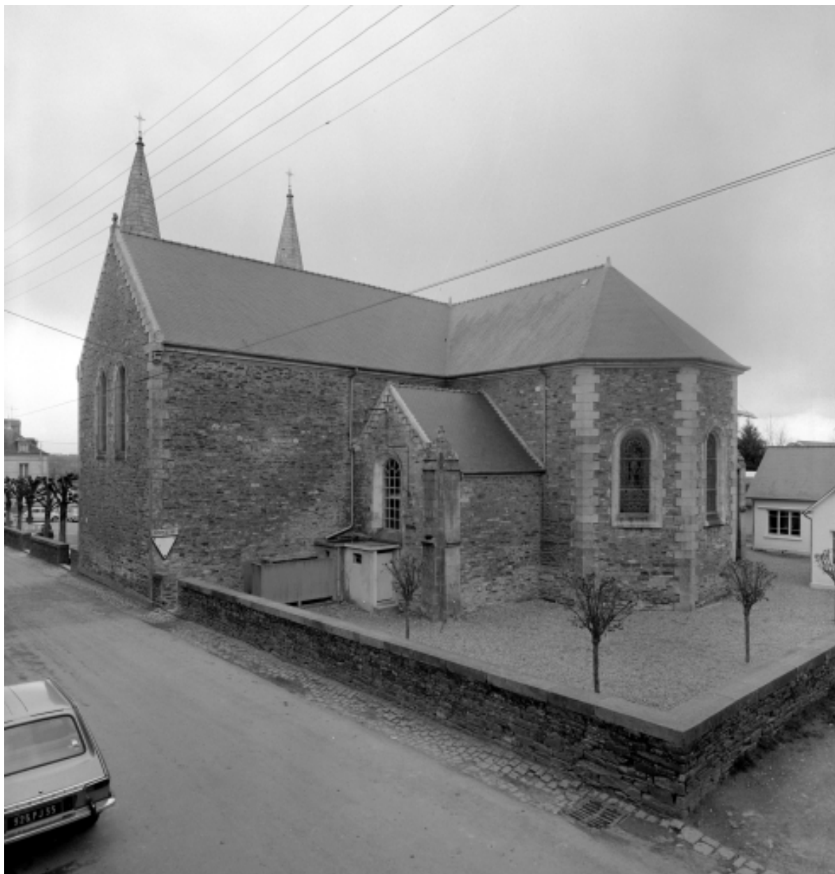
Elévation Nord-Ouest : vue générale
