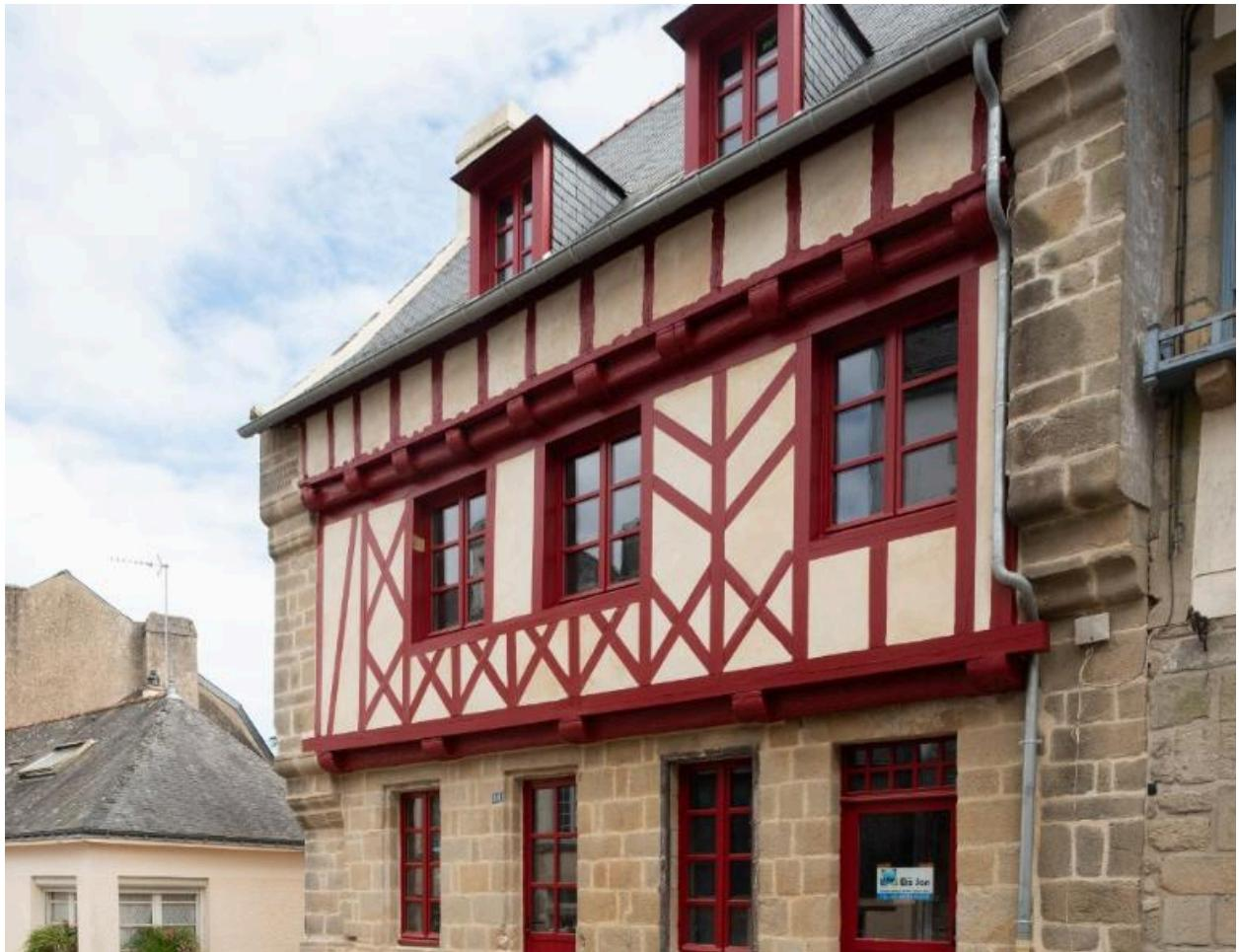
Façade récemment restaurée, avec un rez-de-chaussée maçonné qui n'est pas d'origine.
