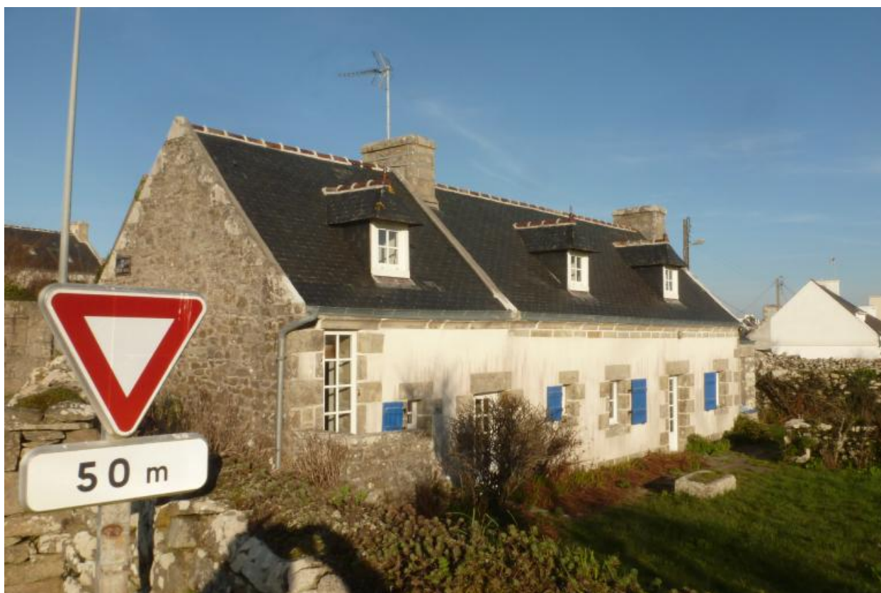
Maison 9, élévation antérieure du logis et de la crèche accolée.
