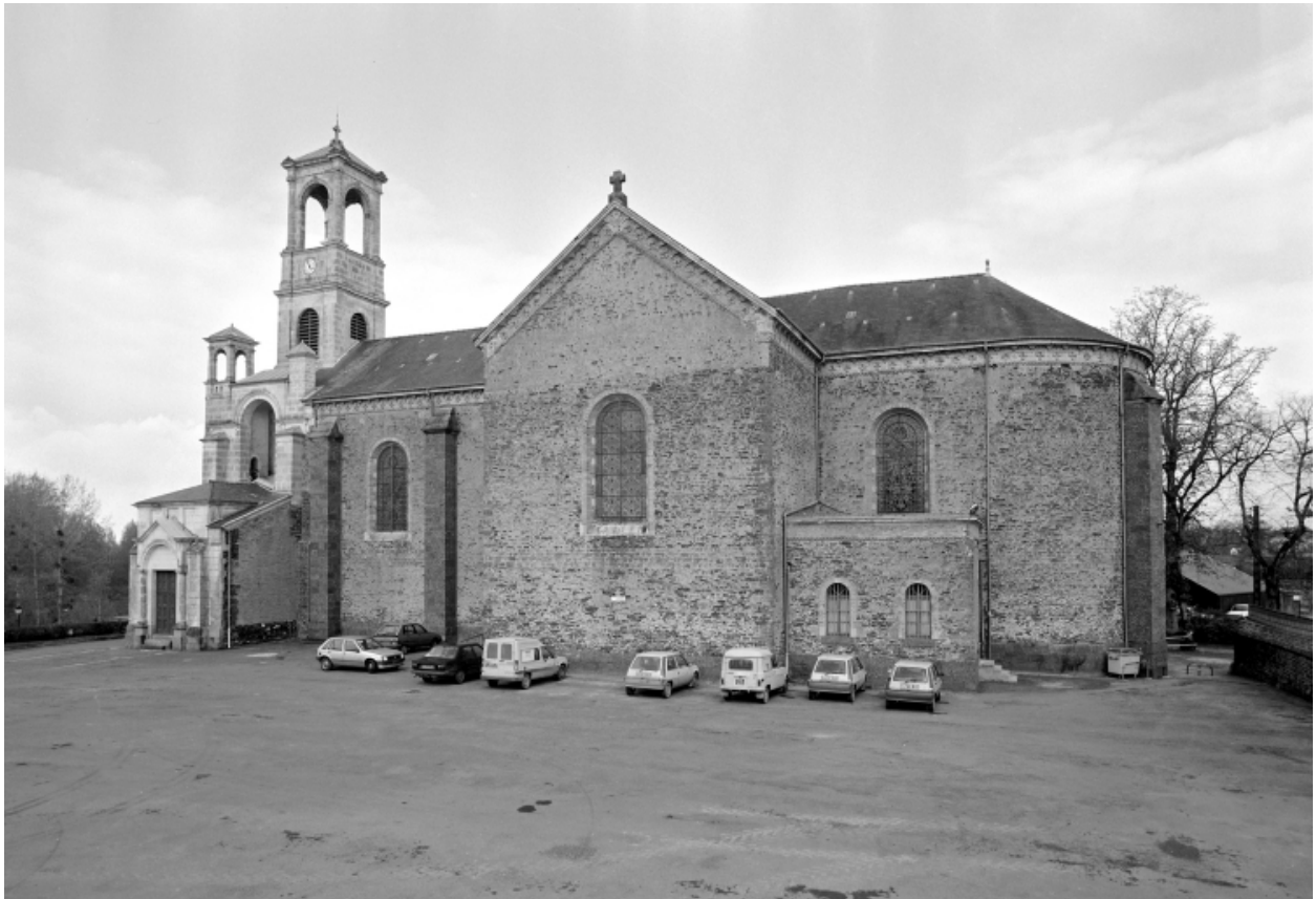
Elévation ouest : vue générale
