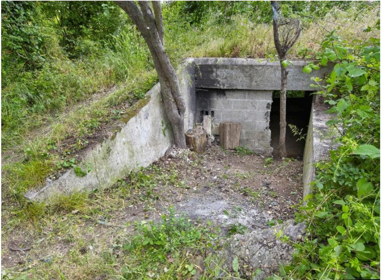
Vue du bunker - casemate de type VF pour un canon de 50 mm situé à l'extrémité Est de la pointe : entrée et rampe d'accès. Les murs latéraux protègent l'entrée qui était camouflée par un filet. L'entrée est partiellement murée par des parpaings et la chambre de tir est remblayée
