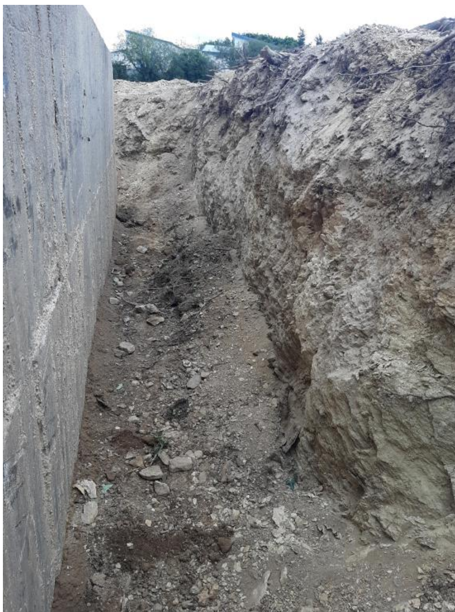
Vue de la déconstruction : mur sud (25 septembre 2022)
