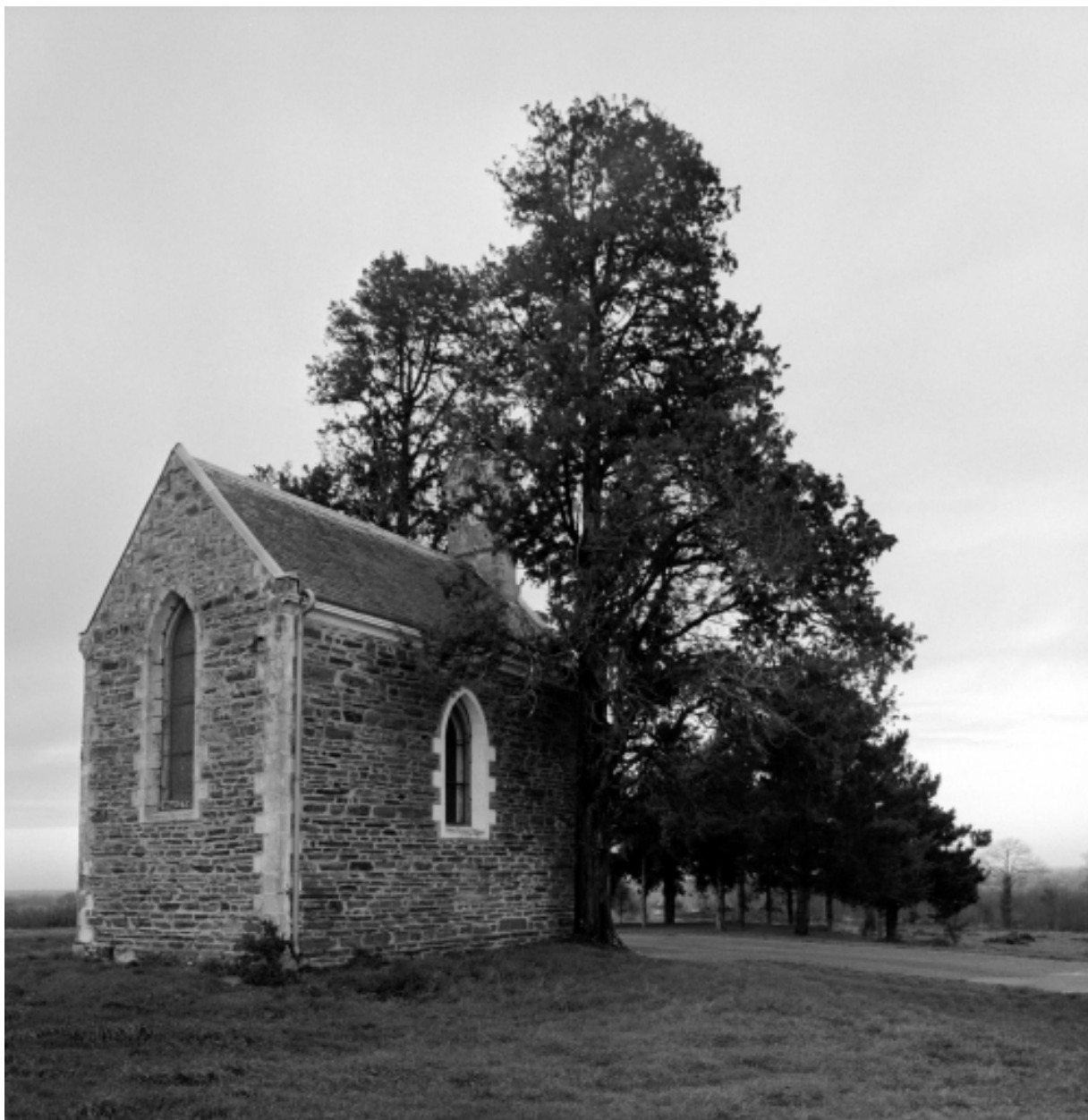
Elévation Est : vue générale
