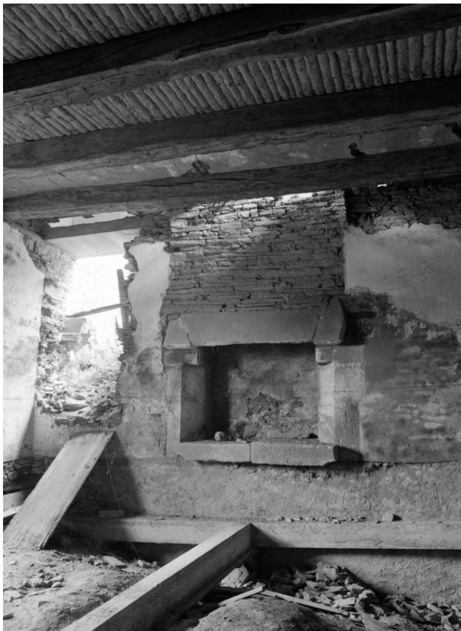
Cheminée, vue générale.
