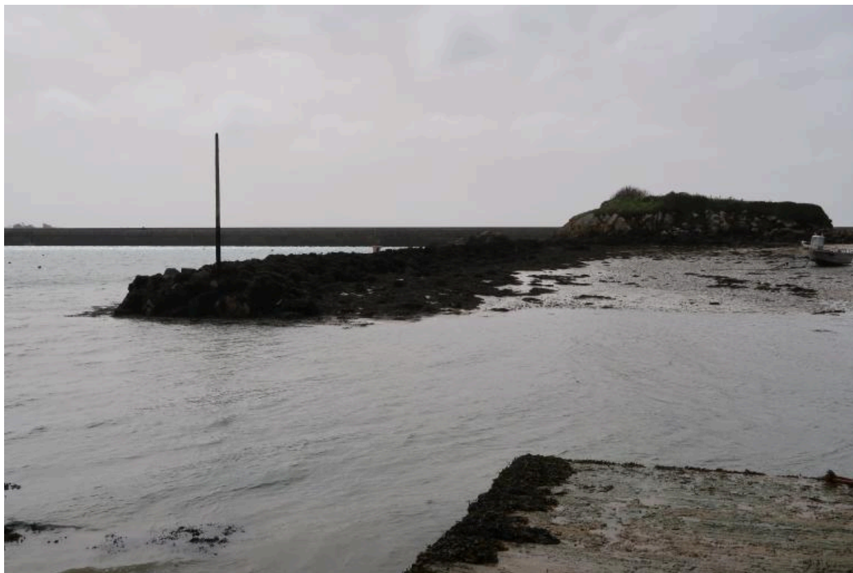
Jetée ouest de pors an eog : blocs de roches (mise en oeuvre en pierres-sèches) protégeant l'anse
