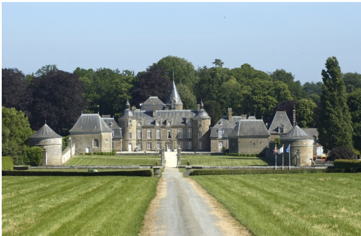
Vue générale sud
