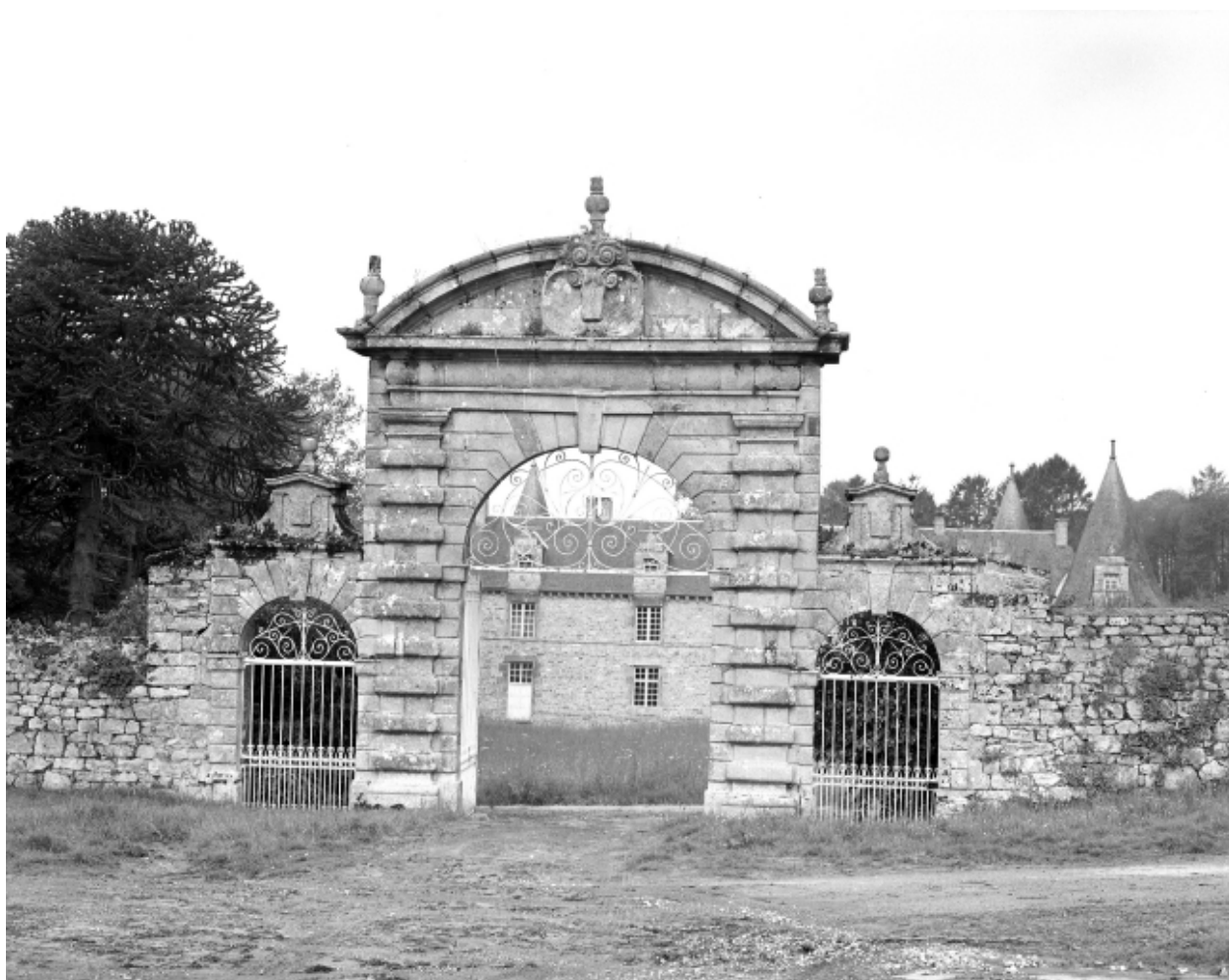
Portail : vue générale.
