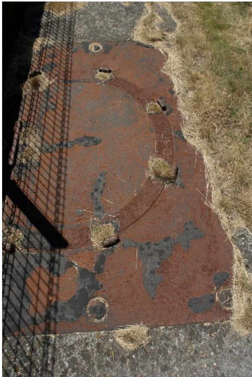
Plouzané : vue du fort du Mengant, détail de la batterie basse, sous-selle d'affût pour canon de 47 mm à tir rapide
