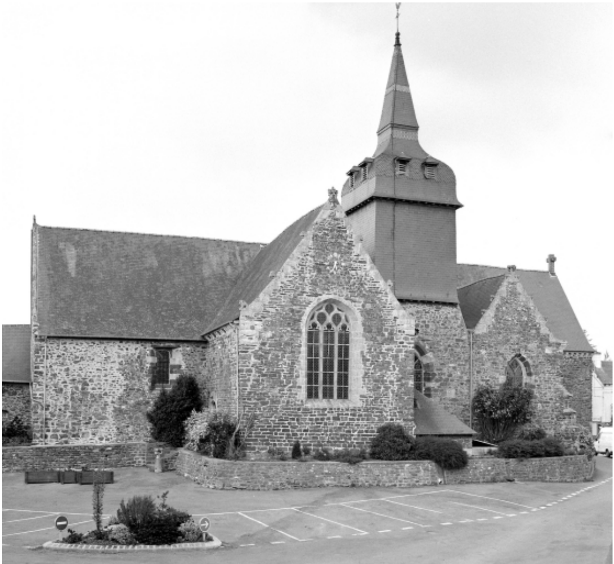
Élévation Sud : vue générale
