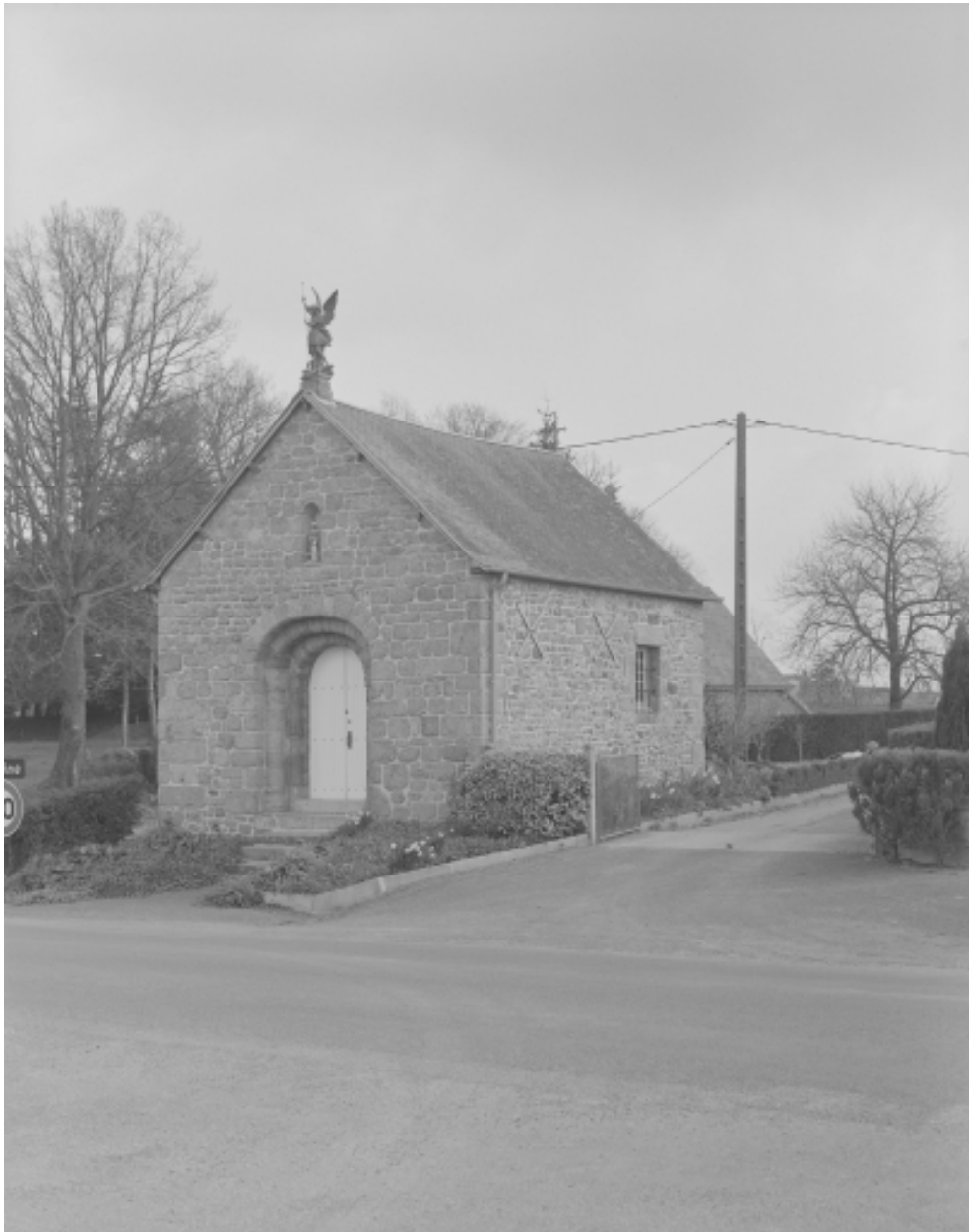
Elévation Sud-Ouest : vue générale
