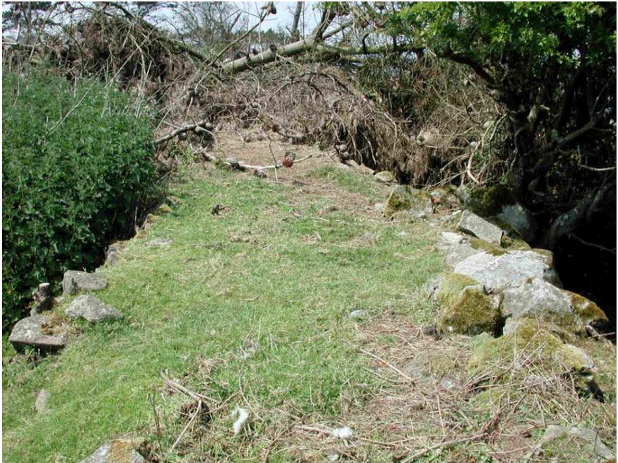
Plouézoch : vue du parapet en maçonnerie et du massif de terre de de la batterie de Perrohen. Il mesure environ 1,5 mètre de large
