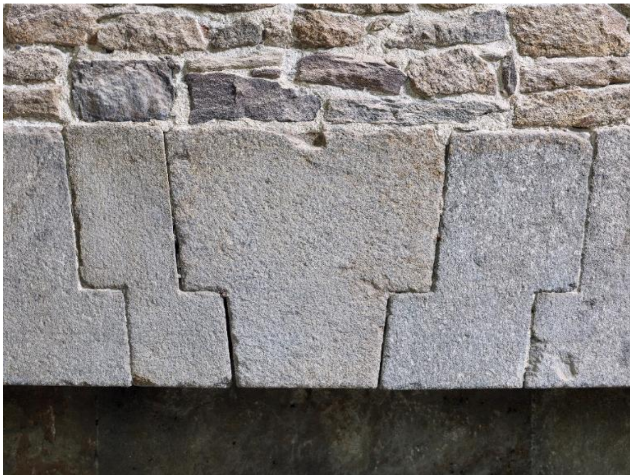
Vue intérieure de la tour Solidor : rez-de-chaussée, pièce intermédiaire, détail de la mise en oeuvre du manteau de cheminée en pierre de taille de granite
