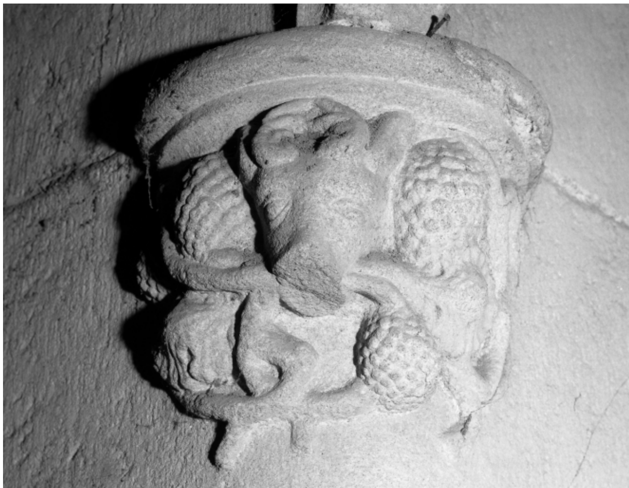
Escalier, 1er repos du rez-de-chaussée : détail du cul-de-lampe nord est
