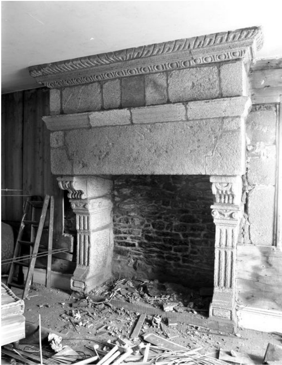
Vue de la cheminée située au premier étage (état en 1985)
