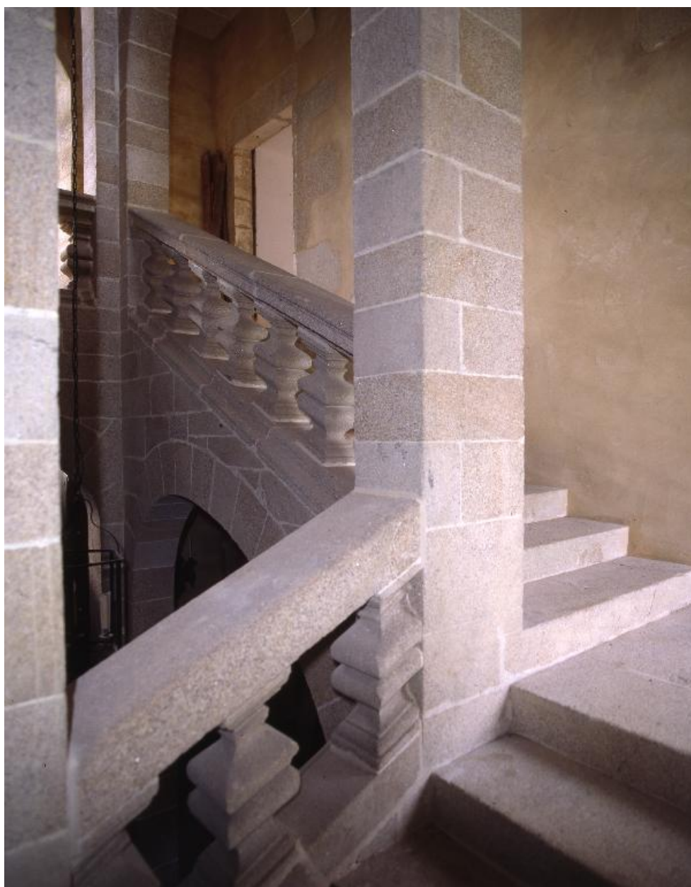
Cage d'escalier, vue vers le 1er étage, état en 2000
