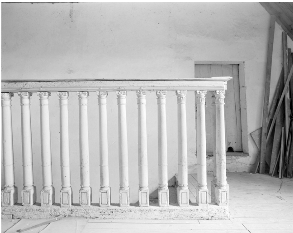
Vue générale de la balustrade au sommet de l'escalier.
