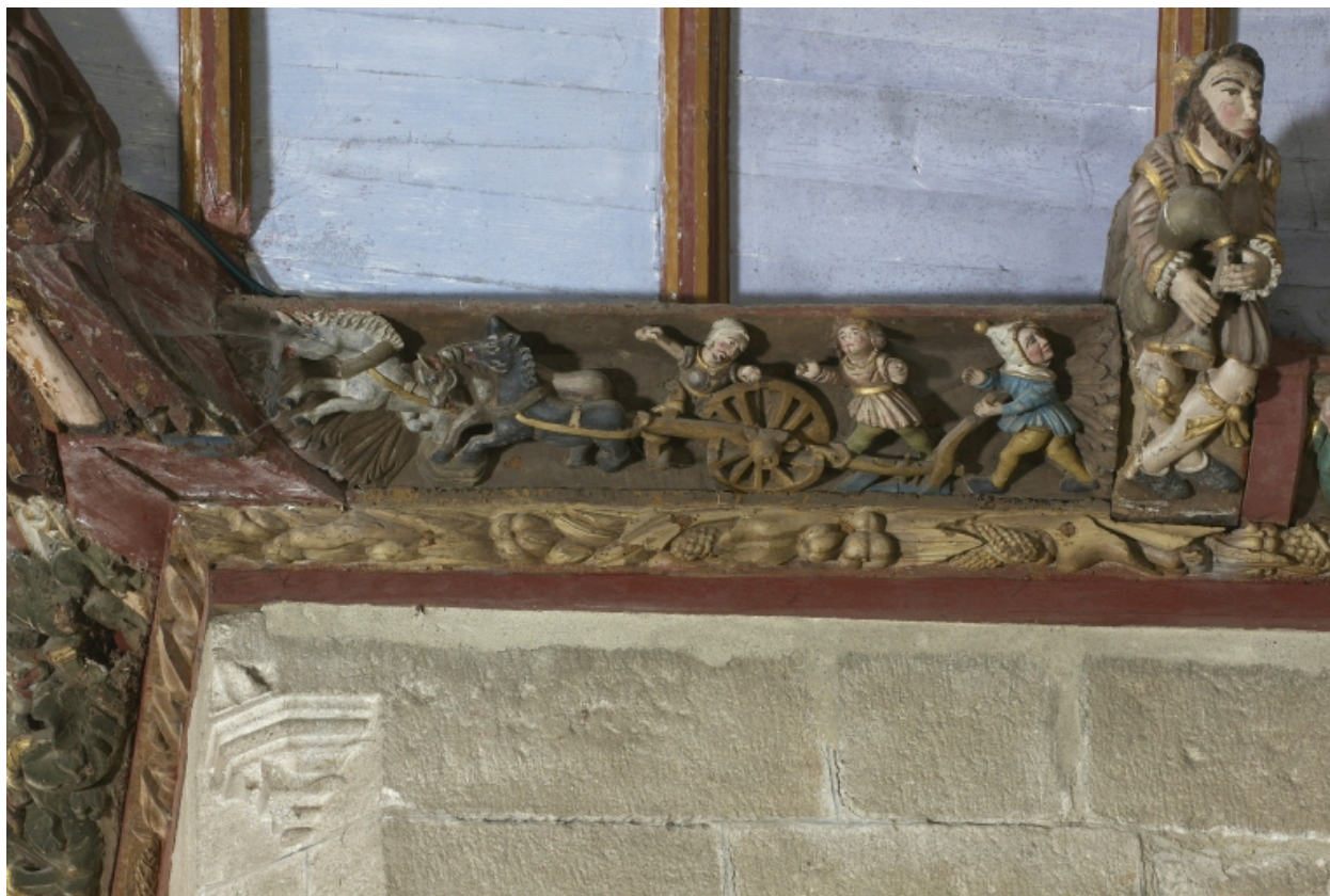
Intérieur, mur sud de la nef, détail de la sablière
