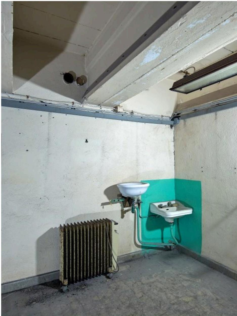
Vue de l'angle nord-est : lavabo et rince-oeil muraux. Le plafond est constitué de poutres préfabriquées en béton armé avec plafonnier à lampe fluorescente. A gauche, radiateur électrique
