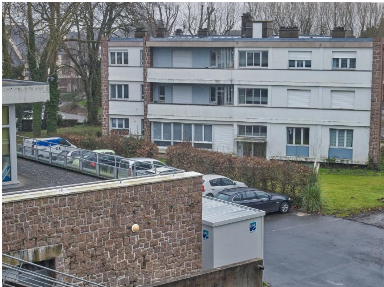
Façade nord-ouest des logements. Au premier plan, terrasse de l'étage du réfectoire. R. Hummel, R. Rolland et A. Weinstein, architectes, 1961.
