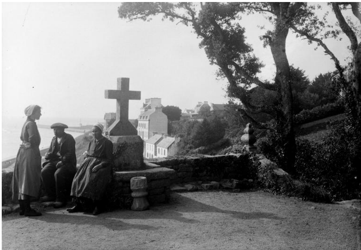
Terrasse et croix donnant sur la passerelle métallique. Reproduction négatif Villard, Quimper.
