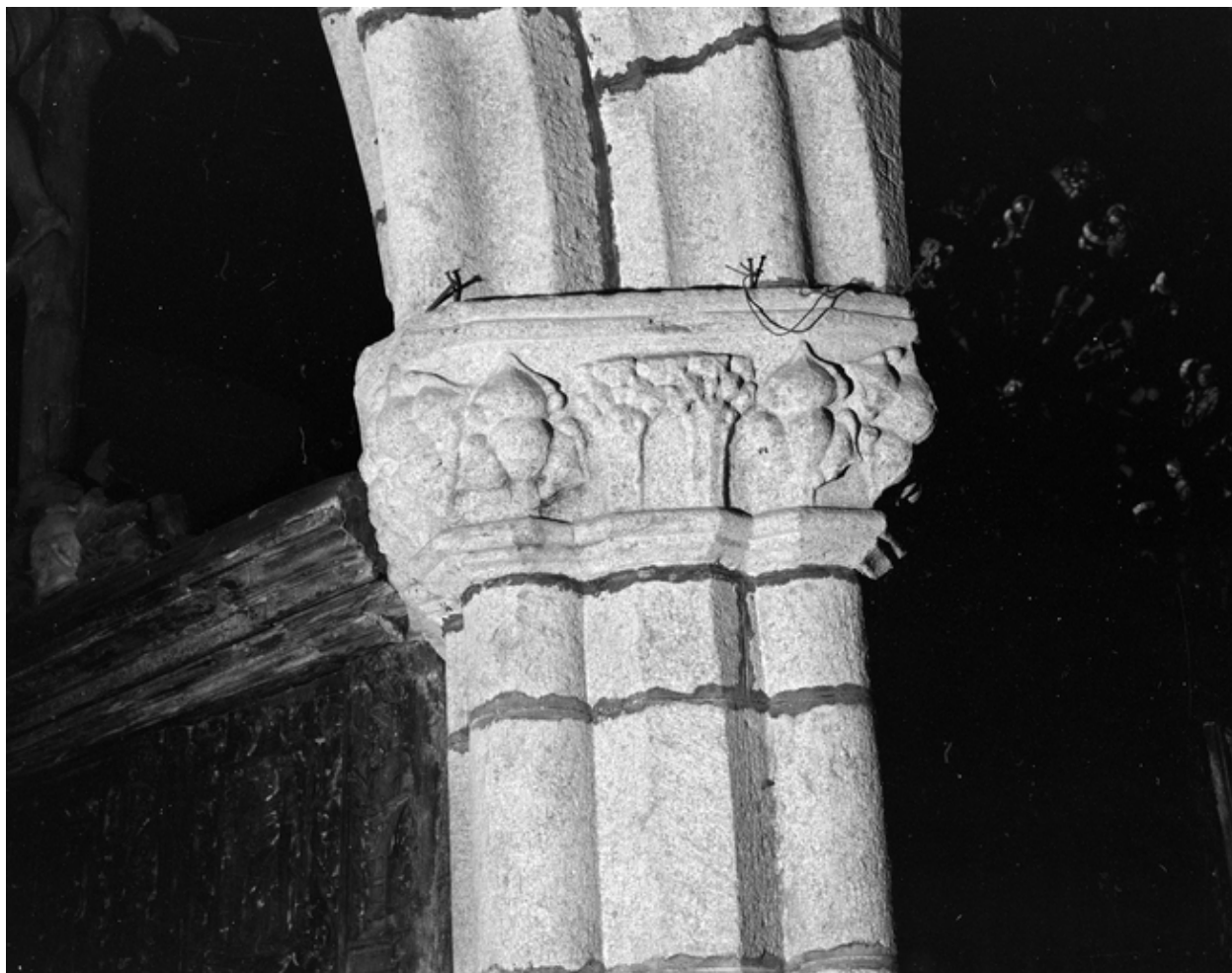
Quatrième pile sud, chapiteau
