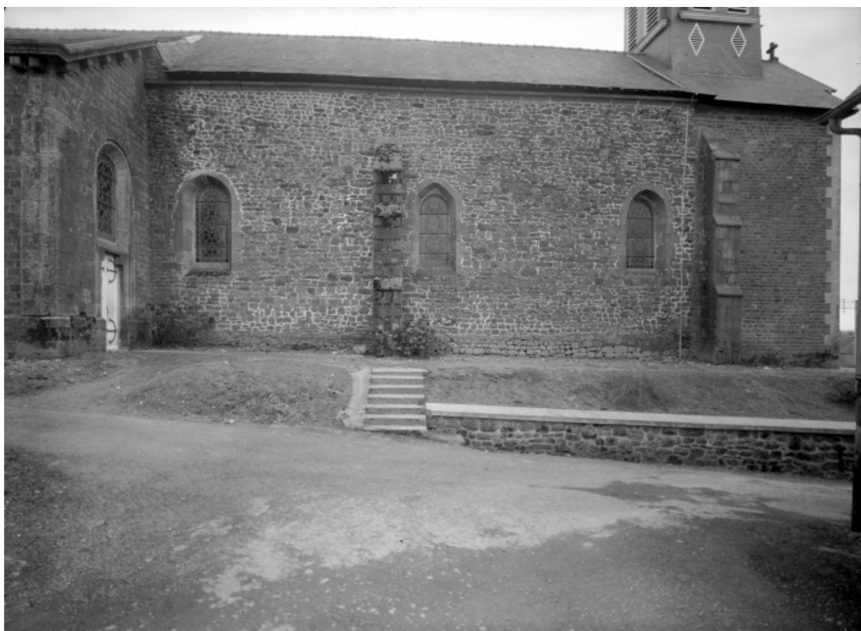
Elévation Nord, nef : vue générale
