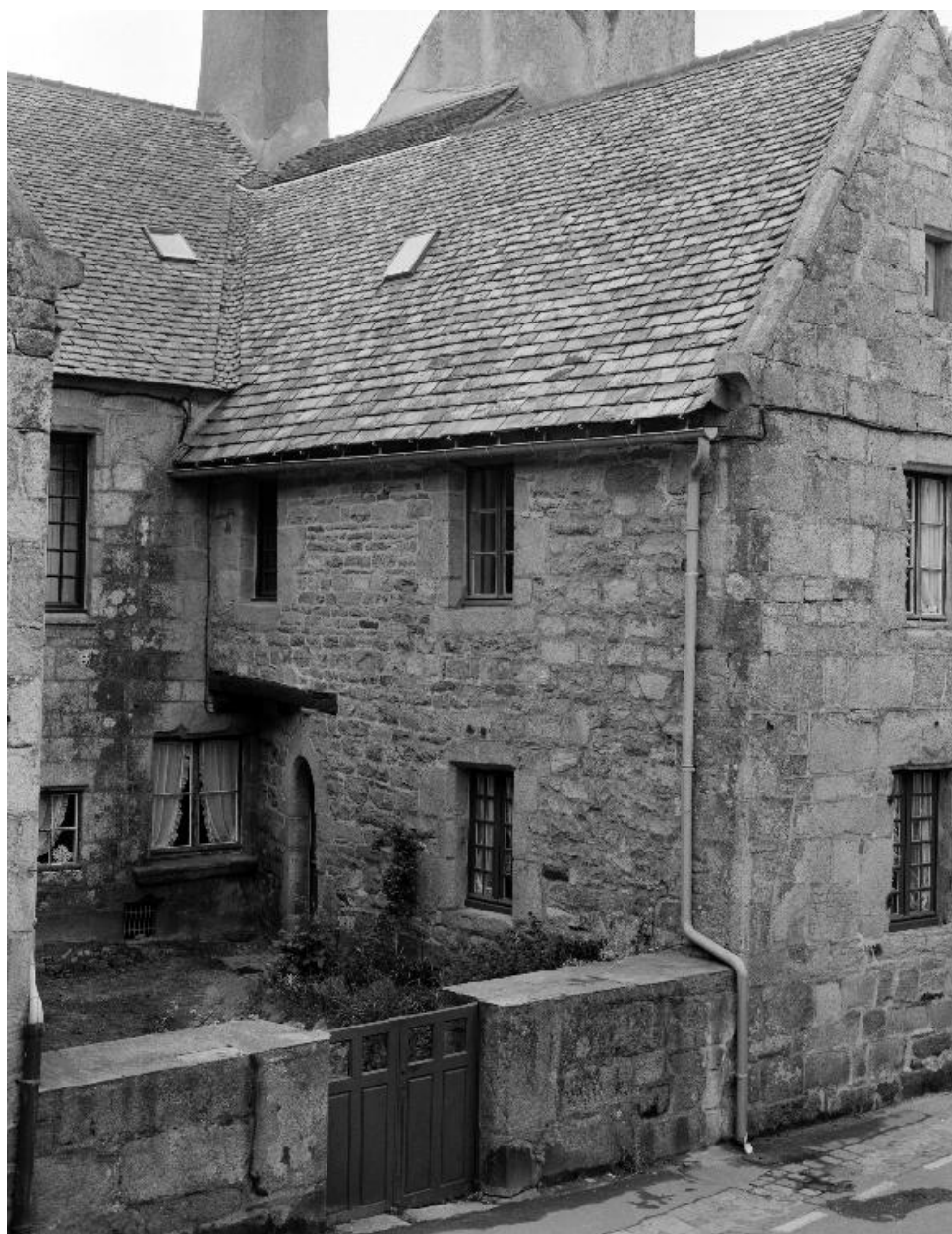
Aile droite, élévation sud
