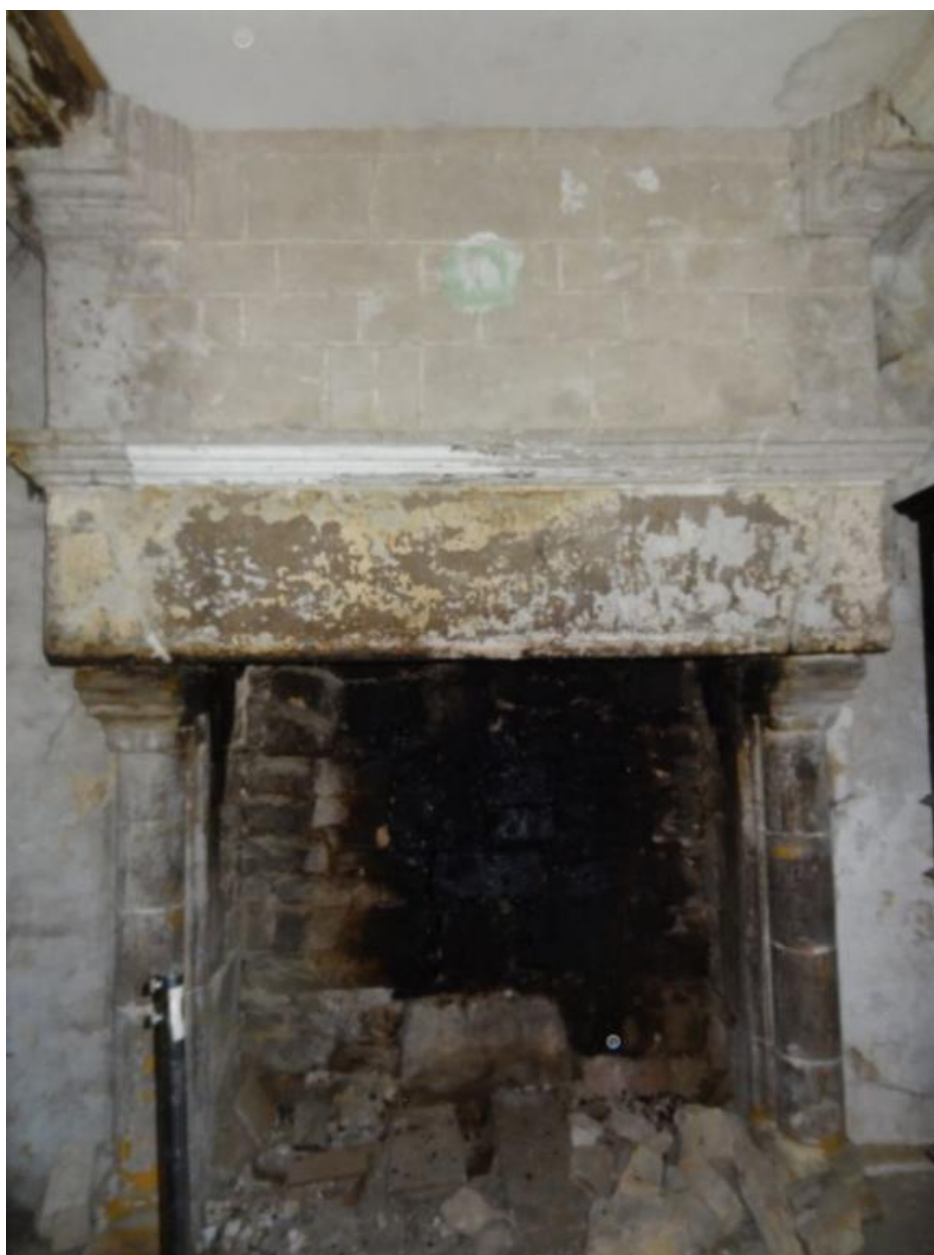
Cheminée de la pièce sud du premier étage
