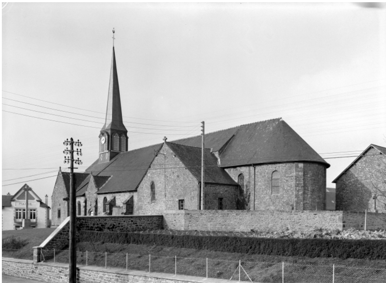
Élévation Sud-Est : vue générale
