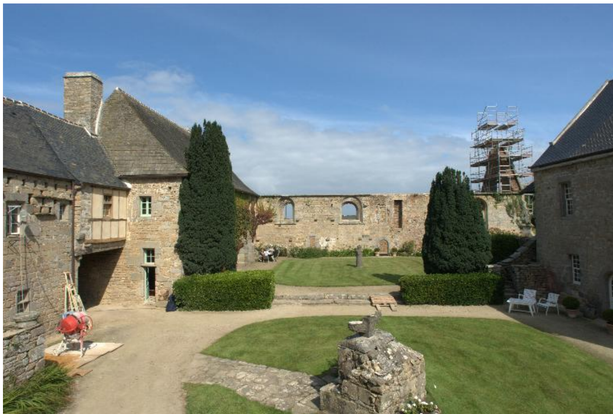
Vue de la façade sud depuis la cour intérieure
