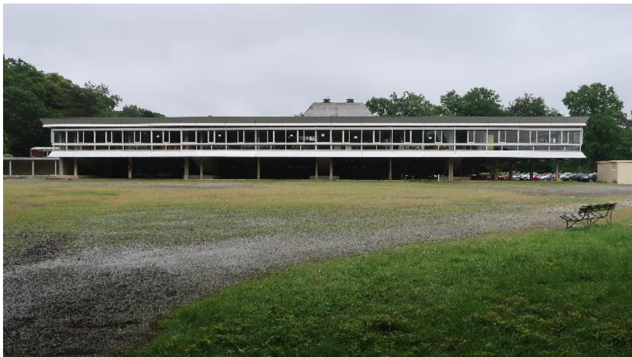
Le service de restauration en 2018, façade ouest.
