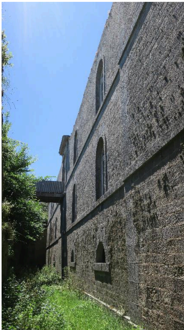
Hoedic, fort central, caserne à l'épreuve, façade est.
